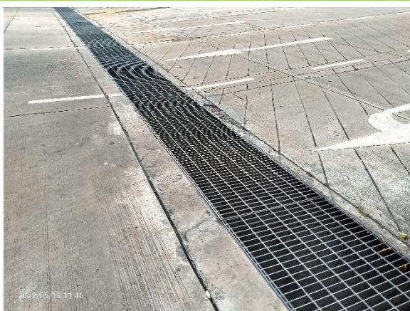
รูปที่ 3-77 รางระบายน้ำรอบพื้นที่โครงการ
