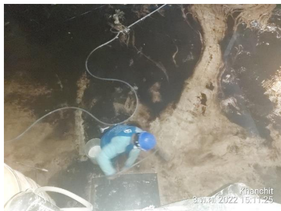
รูปที่ 3-23 การล้างทำความสะอาดถังสำรองน้ำใช้ของโครงการ
