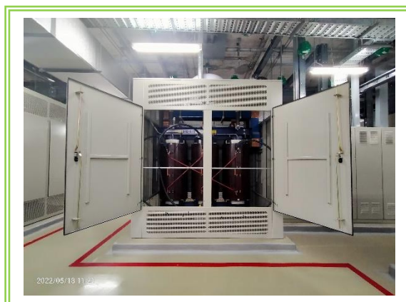
รูปที่ 2.5-7 หม้อแปลงไฟฟ้าชนิดแห้ง
