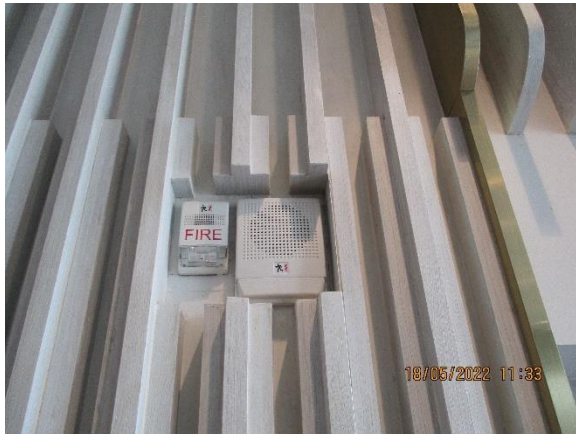
รูปที่ 3-50 ลำโพงแจ้งสัญญาณเตือนเพลิงไหม้
