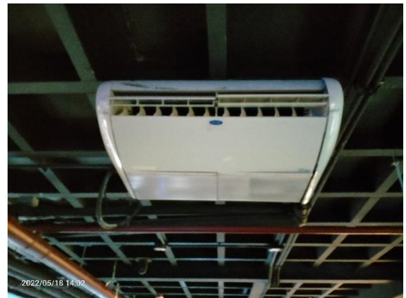
รูปที่ 3-67 เครื่องปรับอากาศ Fan Coil Unit (FCU)
