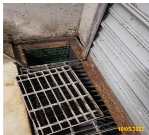
รูปที่ 3-27 ตะแกรงดักมูลฝอย
