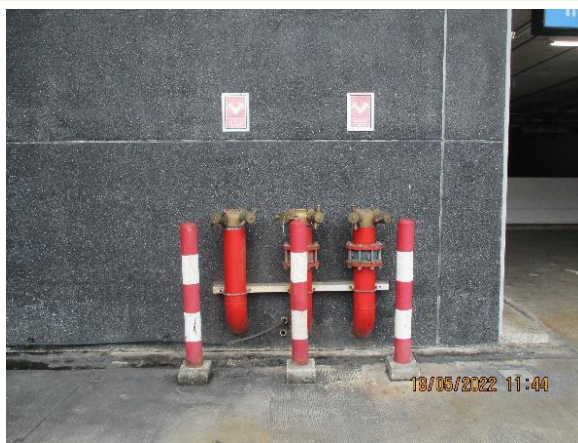
รูปที่ 3-56 หัวรับน้ำดับเพลิงภายนอกอาคาร
